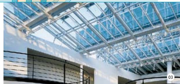
01. Die leistungsstarke Sonnenschutzbeschichtung macht es möglich: INFRASTOP® wehrt einen Großteil der Wärmestrahlen der Sonne ab und lässt gleichzeitig viel Tageslicht herein.
